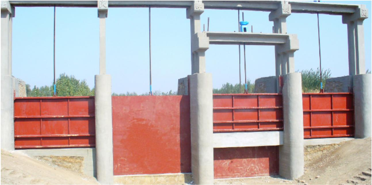
水闸由闸室、上游连接段和下游连接段组成（图2）。闸室是水闸的主体，设有底板、闸门、启闭机、闸墩、胸墙、工作桥、交通桥等。闸门用来挡水和控制过闸流量，闸墩用以分隔闸孔和支承闸门、胸墙、工作桥、交通桥等。底板是闸室的基础，将闸室上部结构的重量及荷载向地基传递，兼有防渗和防冲的作用。闸室分别与上下游连接段和两岸或其他建筑物连接。上游连接段包括：在两岸设置的翼墙和护坡，在河床设置的防冲槽、护底及铺盖，用以引导水流平顺地进入闸室，保护两岸及河床免遭水流冲刷，并与闸室共同组成足够长度的渗径，确保渗透水流沿两岸和闸基的抗渗稳定性。下游连接段，由消力池、护坦、海漫、防冲槽、两岸翼墙、护坡等组成，用以引导出闸水流向下游均匀扩散，减缓流速，消除过闸水流剩余动能，防止水流对河床及两岸的冲刷。
