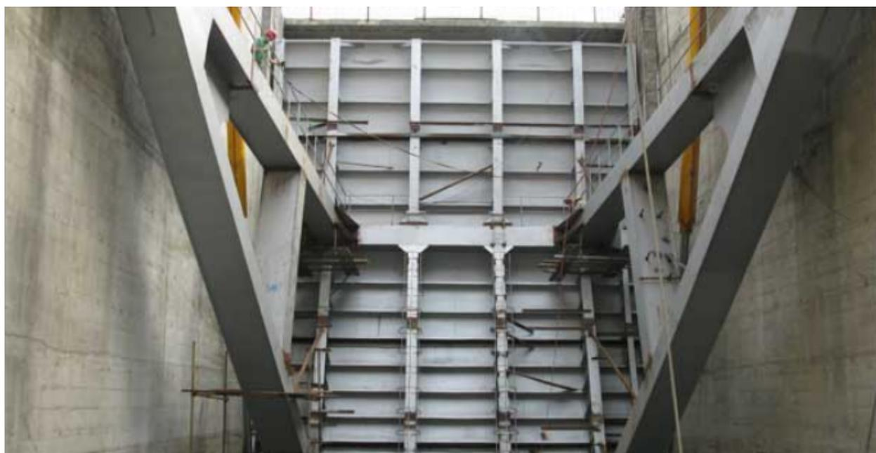
闸门分类方法较多，主要有：①按闸门的工作性质可分为工作闸门、检修闸门和事故闸门。工作闸门也称主要闸门，能在动水中启闭。检修闸门设于工作闸门前。用于建筑物或工作闸门等检修时短期挡水，一般在静水中启闭。事故闸门多设于深孔工作闸门前，用于建筑物或设备出现事故时，能在动水中关闭而在静水中开启；兼作检修闸门时，也称事故检修闸门；需要在限定时间内紧急关闭的事故闸门，称为快速闸门。②按闸门关闭时门顶与水面的相对位置分为露顶式闸门和潜孔式闸门。③按门叶的外观形状分为平面闸门、弧形闸门、人字闸门、拱形闸门、球形闸门和圆筒闸门等。④按制造门叶的材料分为钢闸门、铸铁闸门、不锈钢闸门、铸铁镶铜闸门、木闸门、钢筋混凝土闸门和组合材料闸门。另外，有些闸门，如翻板闸门可借助水力自动启闭，称为水力自动闸门。选择闸门形式需要考虑其在水工建筑物中的位置、尺寸、设计水头、运用条
